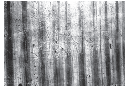
2. La parete del corridoio 52 con i graffiti (Foto: Soprintendenza Pompei).
